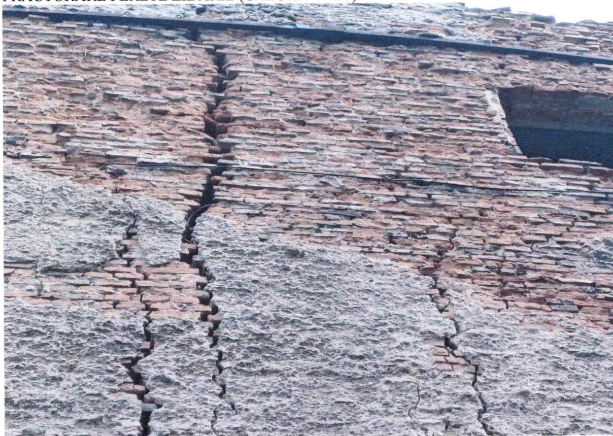
FRACTURARE PERETE ZIDARIE (CALCAN VEST)
