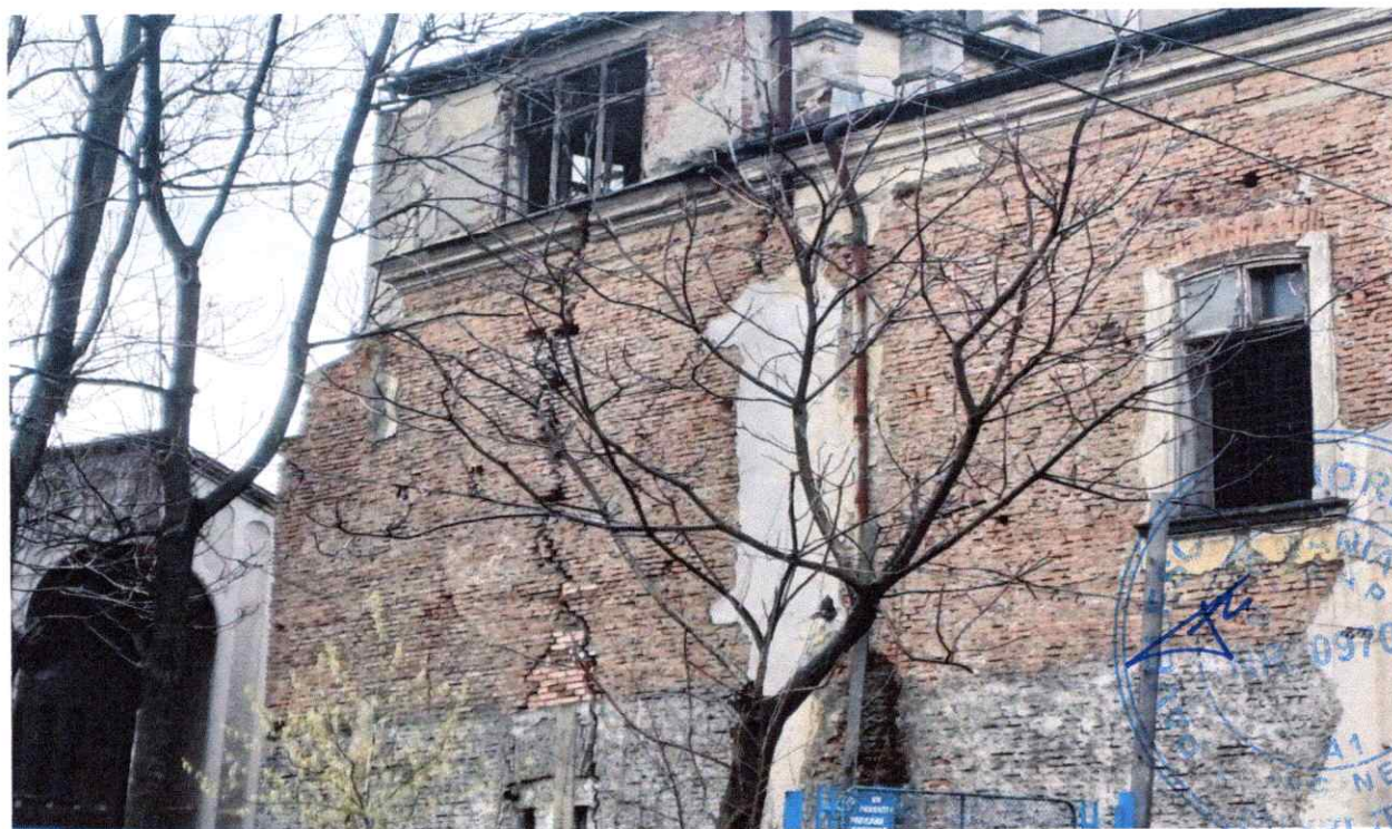
FRACTURARE PERETE ZIDARIE (CALCAN EST)
