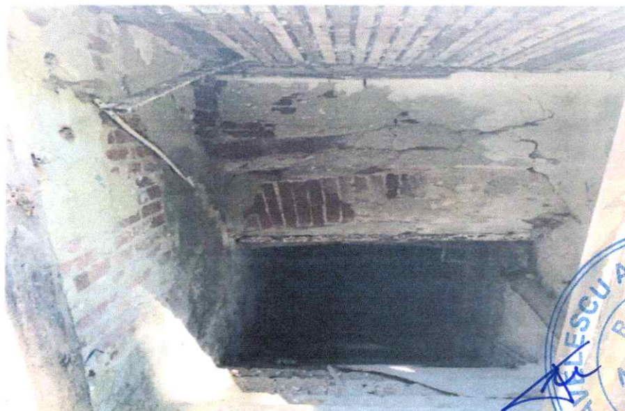
Fig.7. Infiltrații de apă în pereții subsolului Sursa: arhiva Companiei Municipale pentru Dezvoltare Durabilă, București
