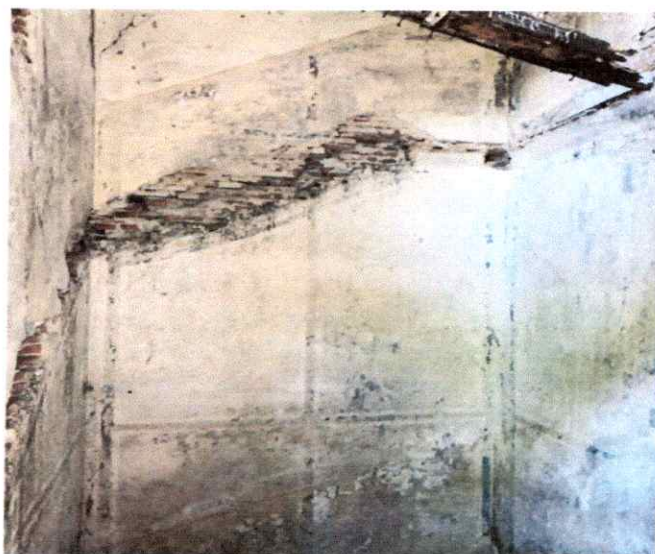
Fig.9. Casa scării – urmele scării din beton armat astăzi distrusă lăsate în pereții de zidărie Sursa: arhiva Companiei Municipale pentru Dezvoltare Durabilă, București
