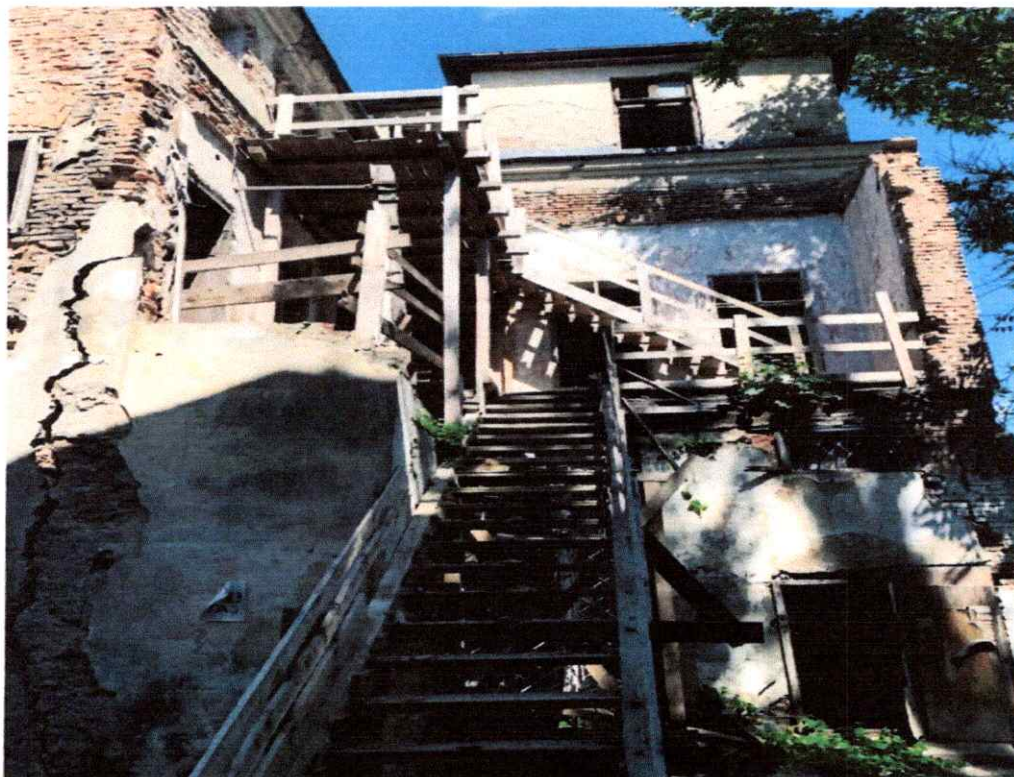
Fig.5. Degradări severe ale fațadei posterioare; cursiva din lemn care asigură accesul la etaj Sursa: arhiva Companiei Municipale pentru Dezvoltare Durabilă, București
