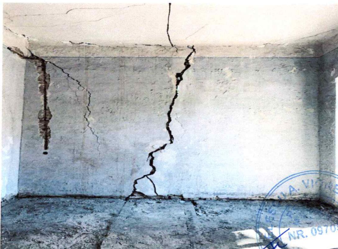
Fig.12. Fisuri adânci în pereții încăperilor de la etaj Sursa: arhiva Companiei Municipale pentru Dezvoltare Durabilă, București
